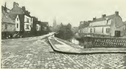
PONT DE LA DODANE. On right of canal; RUE D'ENGOUVAENT On the left; RUE DES MAJOTS. In the background; ST. LEU CHURCH
